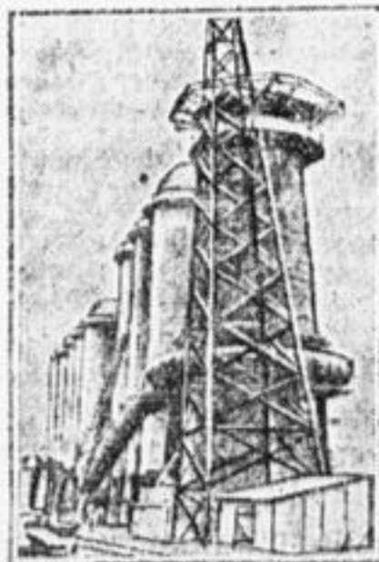
Постройка коксо-бензолного завода в Алчевске.
